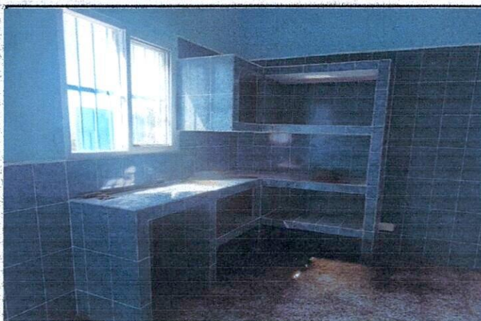
Foto 3: MANTENIMIENTO DE COCINA
