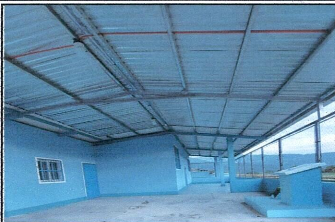
Foto 2: ENTECHADO DE PATIO
